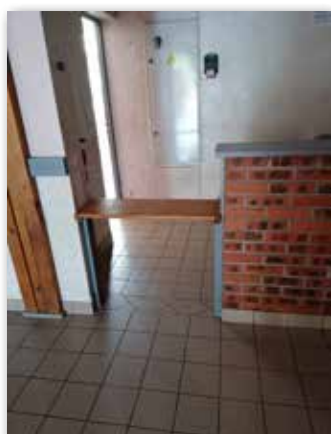
La mise en place de tablettes permettant l'accès d'un fauteuil roulant au bar et au vestiaire. La modification de l'accès au sanitaire handicapé avec la porte donnant directement sur le hall d'entrée.
