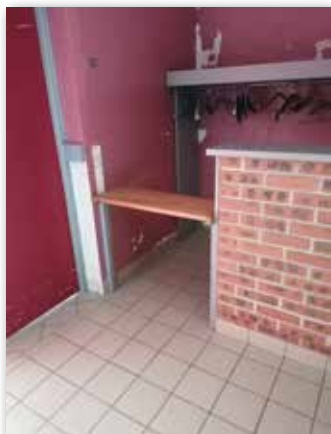
La mise en place de tablettes permettant l'accès d'un fauteuil roulant au bar et au vestiaire. La modification de l'accès au sanitaire handicapé avec la porte donnant directement sur le hall d'entrée.
