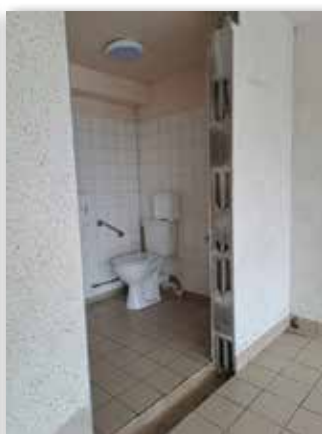
La mise en place de tablettes permettant l'accès d'un fauteuil roulant au bar et au vestiaire. La modification de l'accès au sanitaire handicapé avec la porte donnant directement sur le hall d'entrée.
